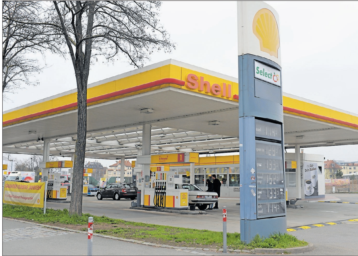
Die Shell-Tankstelle in der Mercedesstraße war viele Jahre nicht nur für Autofahrer eine Anlaufstelle, auch Fans des VfB Stuttgart nutzten sie als Treffpunkt. Foto: Gökalp
